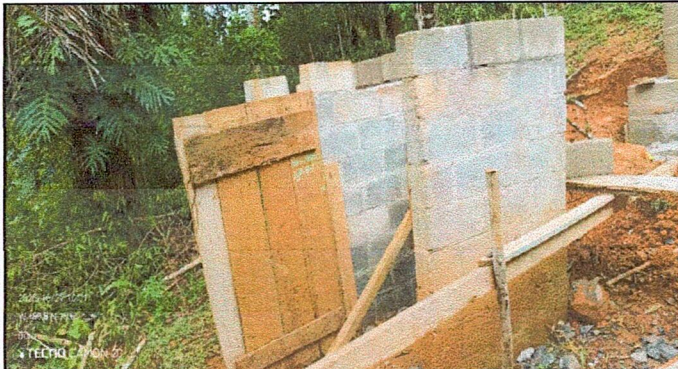
Foto 3: REPARACION DE BAÑOS
